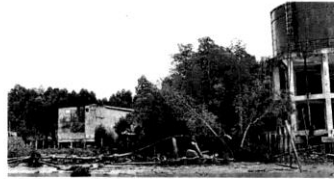
大水槽结构和地基稳固，惟因水压问题而无法蓄水
