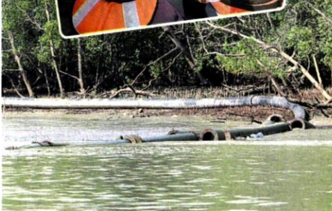
■海底水管位置不当,导致经常被船摩擦撞及,随时被撞破。
